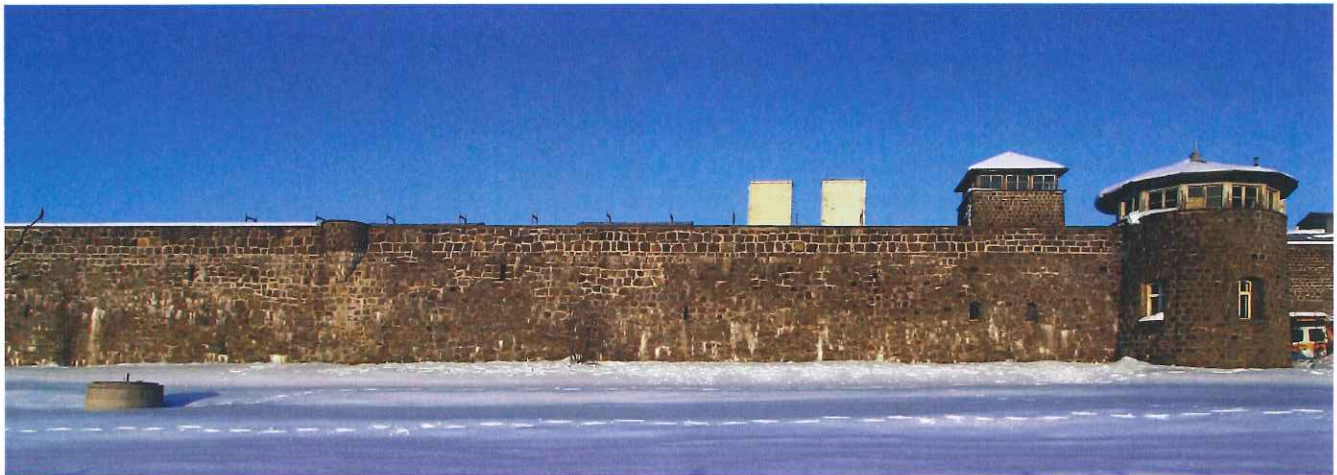
Bild 4 KZ Mauthausen – äußere Umfassungsmauer
