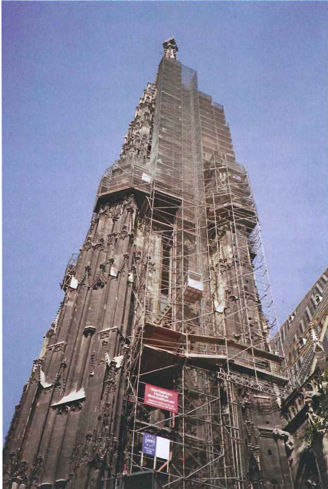
Bild 1 Nach Herstellung von Kernbohrungen wurden GFK- Stangen zur Verstärkung eingebaut und mit Epoxydharz injiziert.
