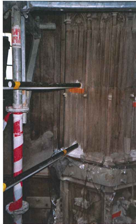
Bild 2 Einbau der Stangen mit Injektionsschlauch
