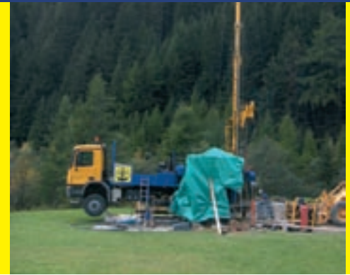
Kernbohrung in Gries am Brenner
